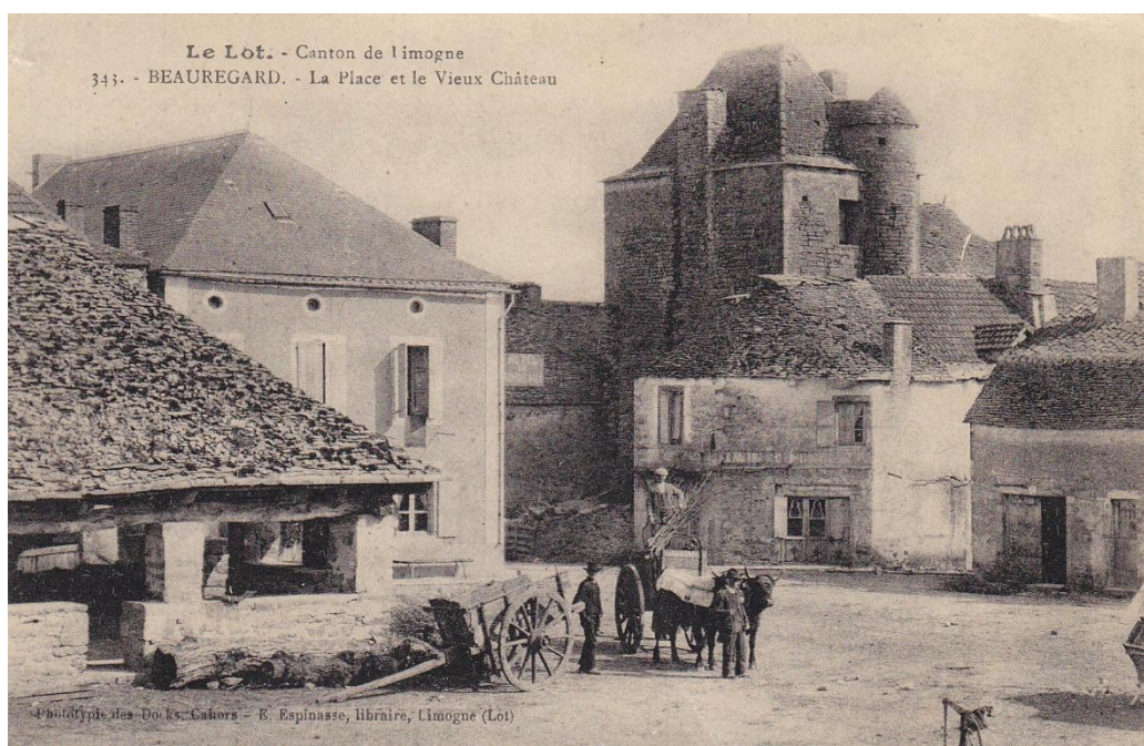
Sur le char Antonin Martiel tenant un fagot, il est boulanger. Il conduit les bœufs de Dujols de Vidaillac.
